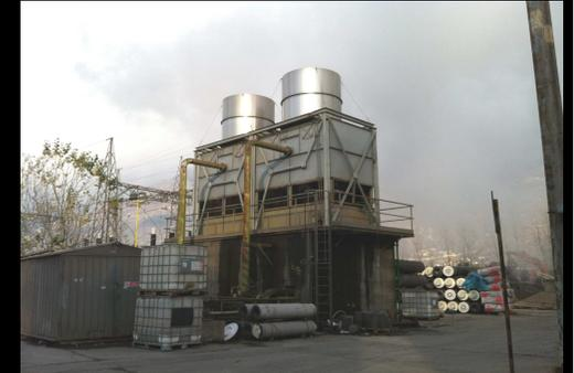
**Silenziatori sui ventilatori della cabina di trasformazione per impianto TECOAER**
