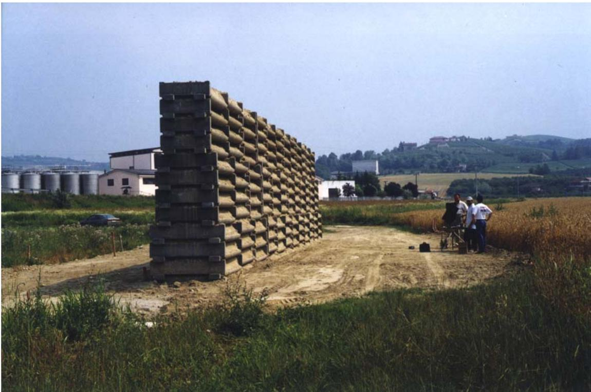
**Fig. 14** - *Barriera muro verde rastremato (a sezione trapezia) costituita da un muro cellulare a gabbia a reticolo spaziale tridimensionale riempita di terra. Il lato rivolto verso la sorgente è tappezzato con piante di diversa essenza.*
