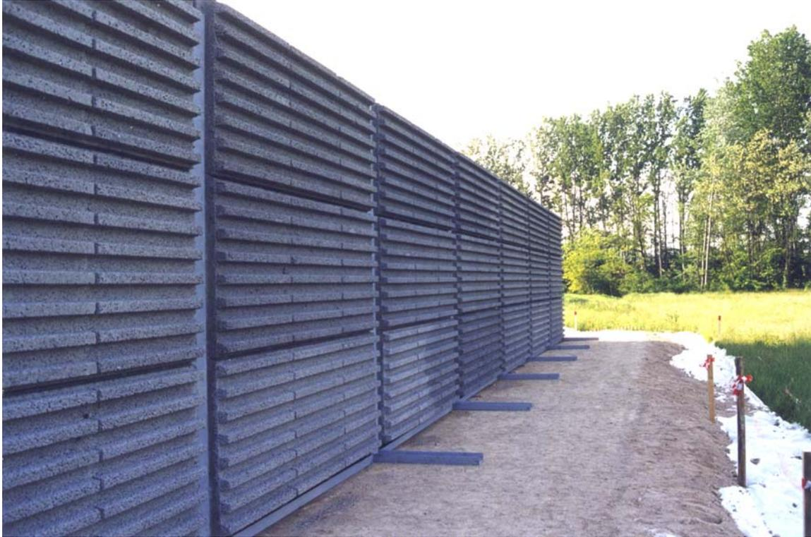
**Fig. 10** - *Barriera acustica sottile con lato rivestito in pomice. L'altro, rivolto verso la sorgente, è rivestito di materiale fonoassorbente (lana minerale).*
