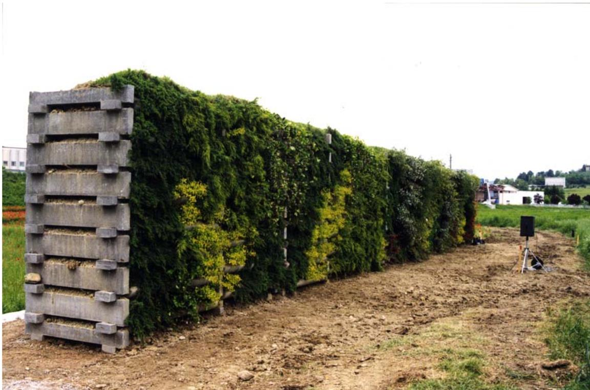
**Fig. 12** - Barriera muro verde costituita da un muro cellulare a gabbia a reticolo spaziale tridimensionale (a sezione rettangolare) riempita di terra. Il lato rivolto verso la sorgente è tappezzato con piante di diversa essenza.
